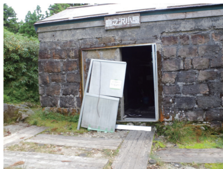
2015年に破壊されていた扉。養生テープは頑張って補修しようとした痕跡。
